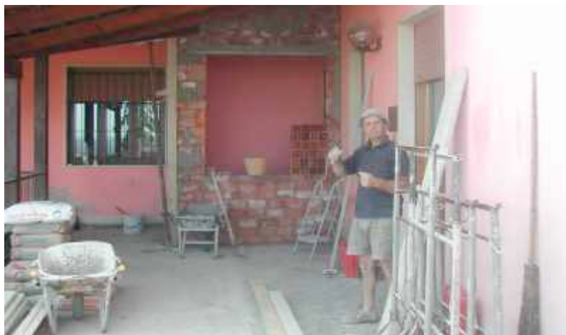
Apertura del cantiere
