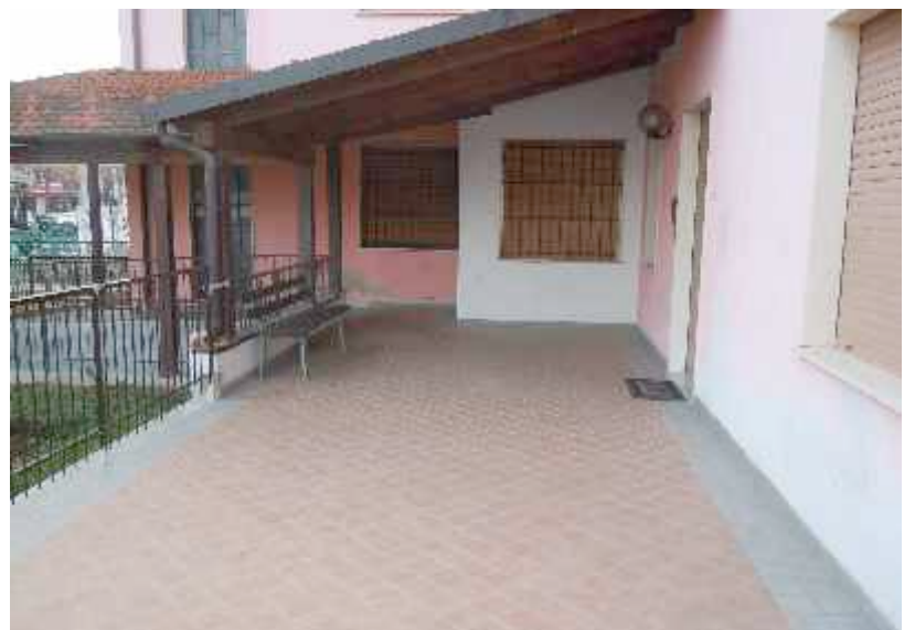
I lavori conclusi
