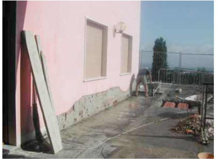
La terrazza oggetto dei lavori
