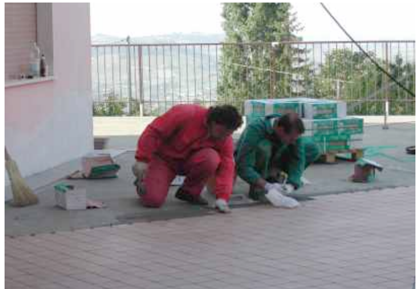
Posa delle piastrelle
