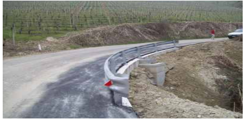
Lavori in strada Brosia
