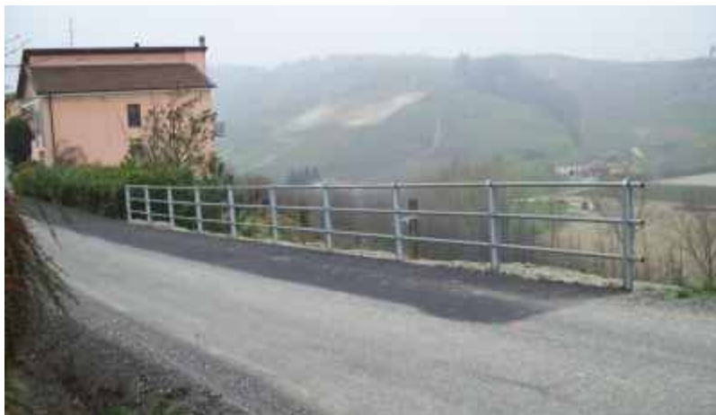
Lavori in strada San Lazzaro
