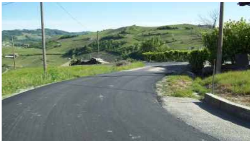
Nuovo asfalto in strada Marini
