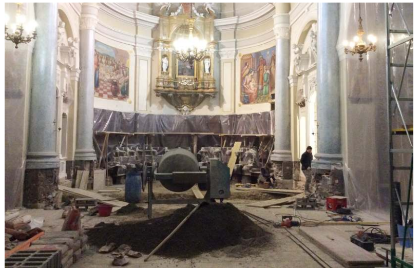
I lavori nel Santuario
