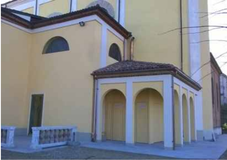
Lavori esterni al Santuario
