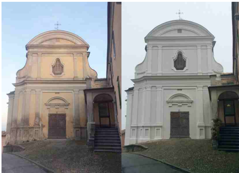
La facciata della chiesa prima e dopo i lavori
