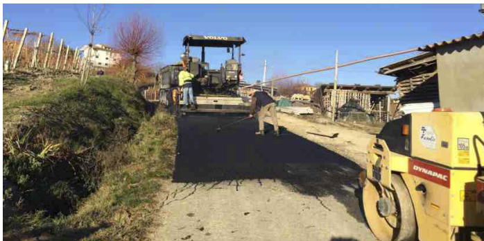
Nuovi asfalti sulla collina dei Manzotti
