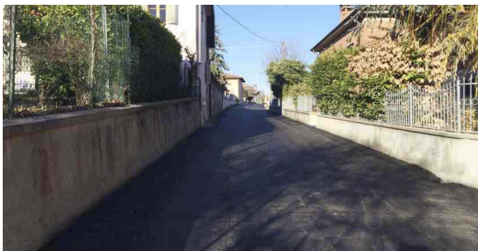
Nuovi asfalti in strada San Lazzaro
