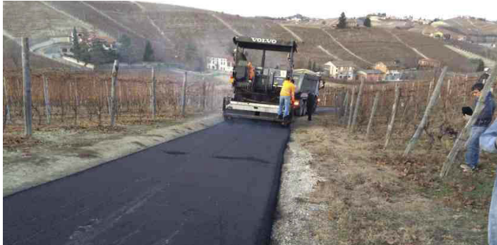
Nuovi asfalti in strada Ghiga
