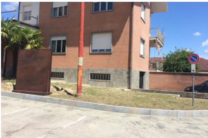
Ripristino area verde
