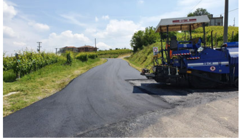
Asfalti in via Marini
