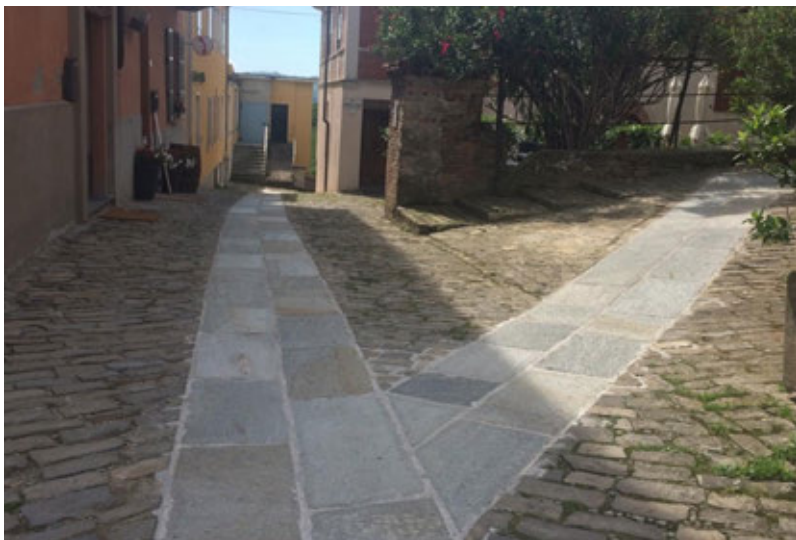
Lavori nel centro storico (1)
