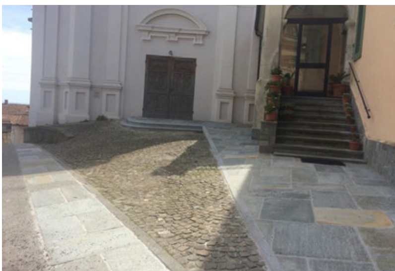
Lavori nel centro storico (2)
