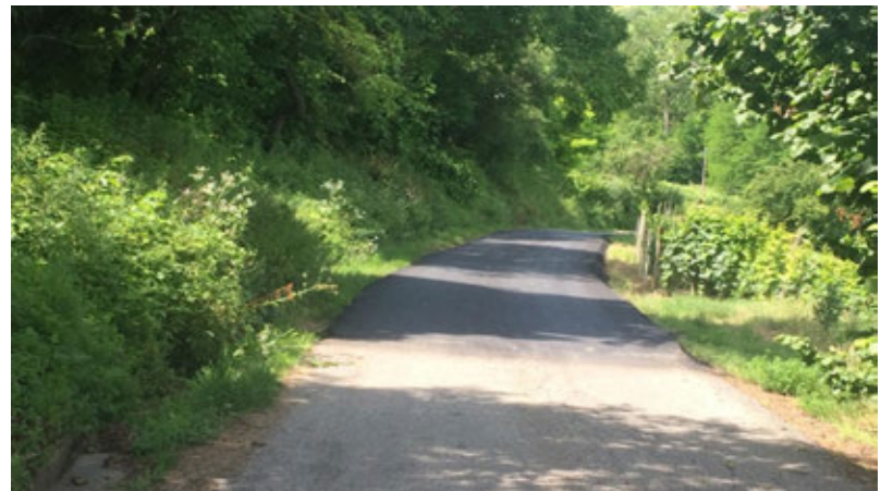
Asfalti in Valle Francesca (1)
