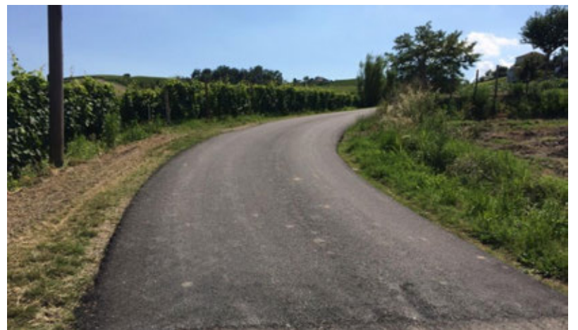
Asfalti in Valle Francesca (2)
