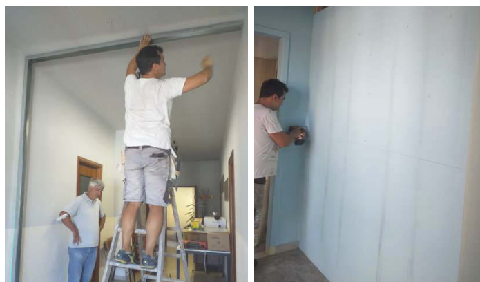
Lavori in biblioteca
