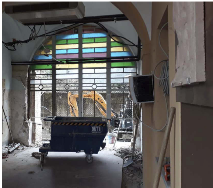
Lavori al Santuario
