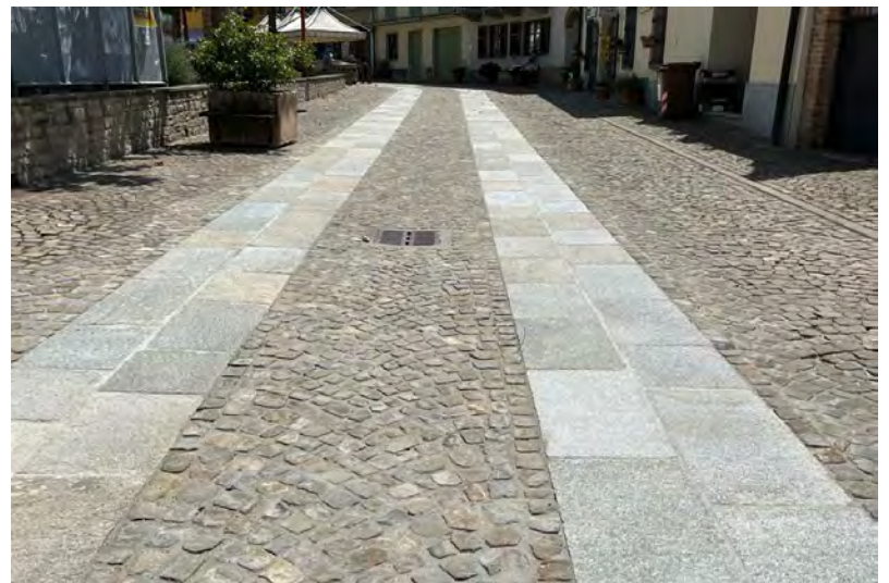
Lavori sulla pavimentazione (4)
