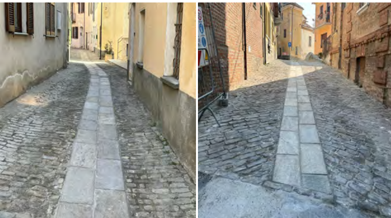
Lavori sulla pavimentazione (1-2)
