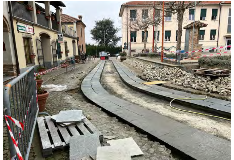
Lavori sulla pavimentazione (3)
