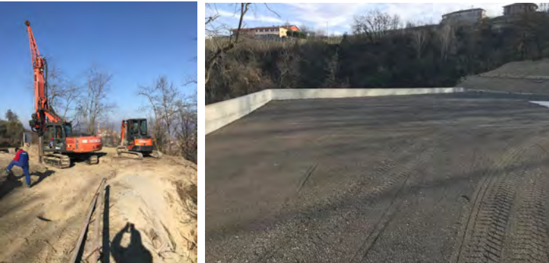
Lavori al sito del magazzino comunale
