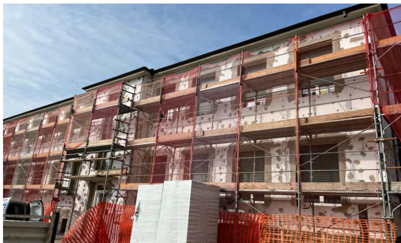
Il cappotto termico all'edificio scolastico (1)
