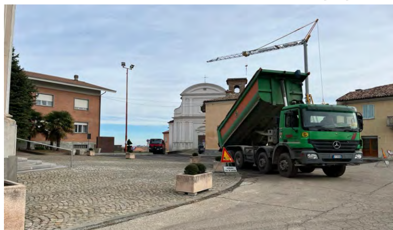
Nuovi asfalti in centro (1)
