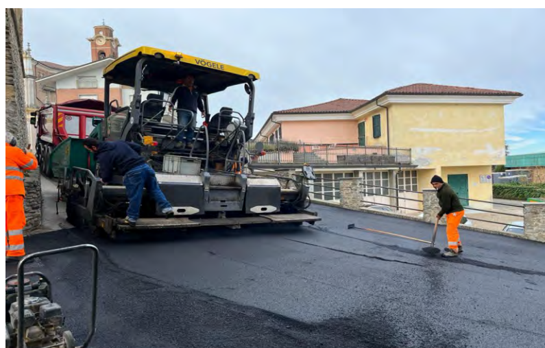
Nuovi asfalti in centro (2)
