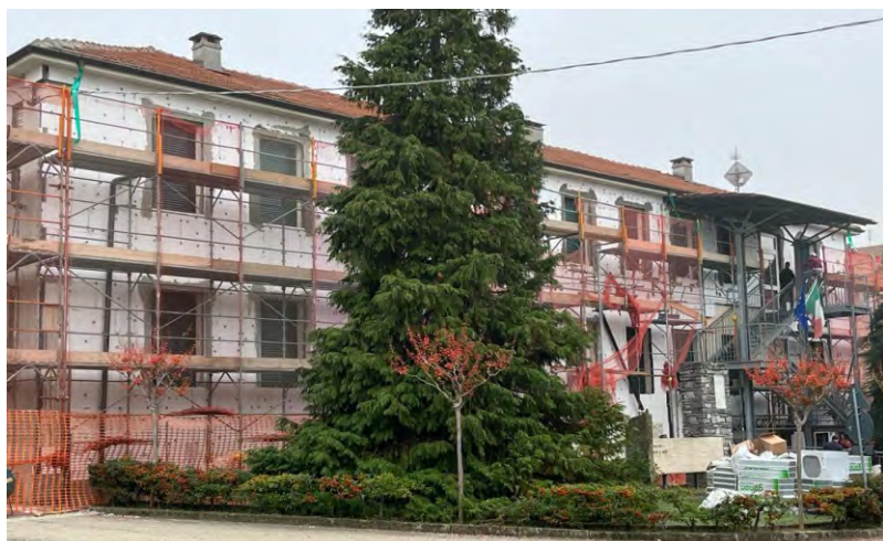
Il cappotto termico all'edificio scolastico (2)
