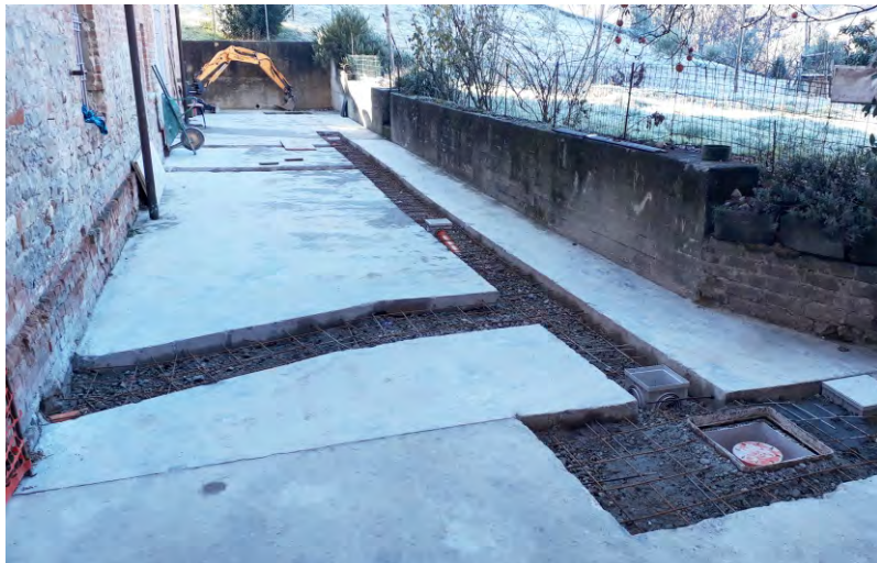
Ultimi lavori al Santuario
