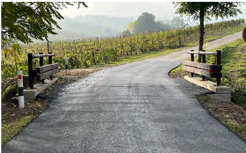
Lavori al ponte in via Ghiga
