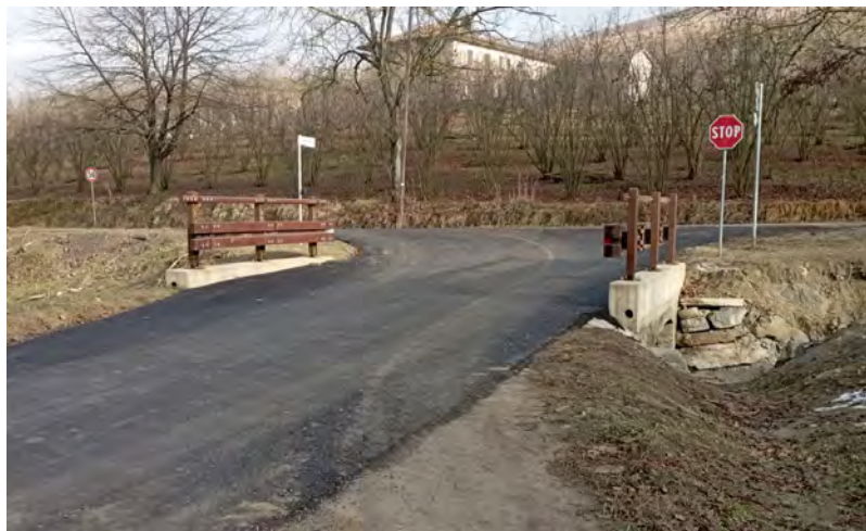
Lavori al ponte di Valle Bera
