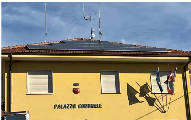
Il fotovoltaico sul tetto del Comune
