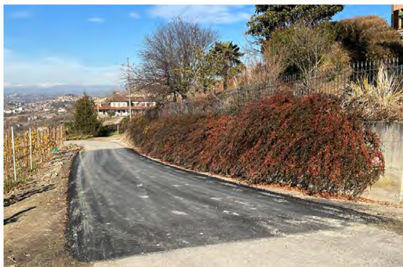
Lavori in via Valle Bera
