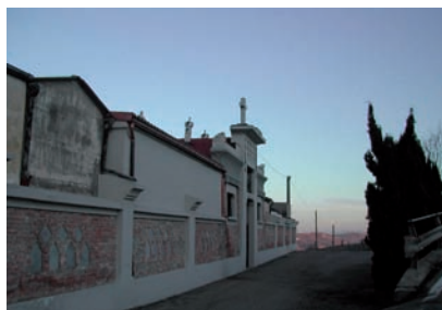
La facciata ristrutturata del cimitero
