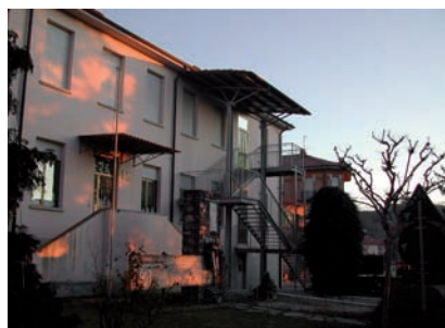
La nuova scala anti-incendio delle scuole
